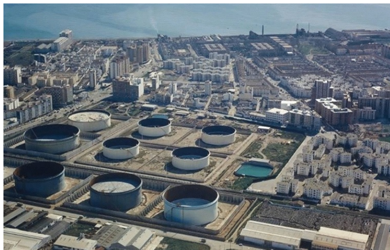
Fig.11. Panorámica de los depósitos de REPSOL en los años 1990
