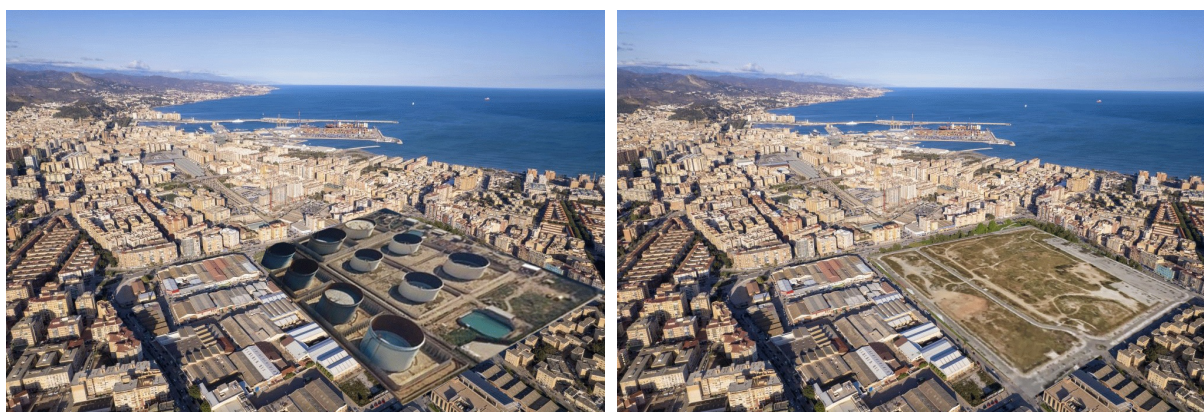
Fig.12. Parcela de los depósitos de REPSOL antes y después de su dismantelamiento
